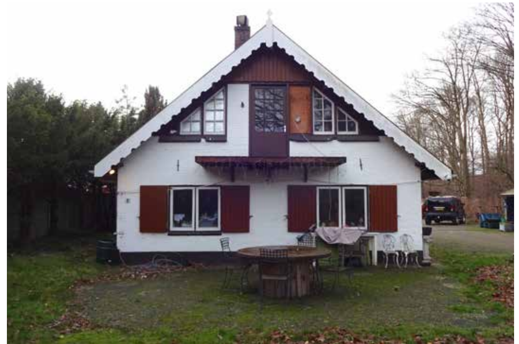
Afb. 25 - De kopse gevel aan de oostzijde in de huidige situatie, 2021
